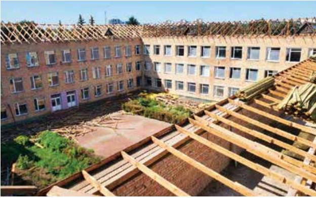
An der Schule in Butscha wurde das während der Kämpfe stark beschädigte Dach mit Projektmitteln von ca. 90.000 € komplett erneuert
